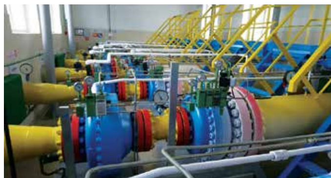
Рисунок 3 – Применение регуляторов давления газа серии HON512 на ГРС
