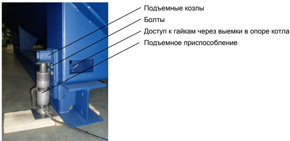
Рисунок 3: Подъем котла с помощью подъемного приспособления (изображение для одной опоры котла)
