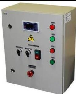
Шкаф управления ВОДОГРЕЙНЫМ или ПАРОВЫМ котлом на базе САФАР-Б3К
